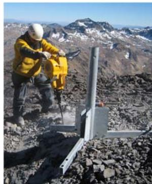
Durch seine schwenkbaren Abstützungen kann er beliebigen Geländeformen angepasst werden. Dadurch sind die Schneedriftstationen ohne Betonfundation auf beliebigem Untergrund montierbar, was die Installationskosten erheblich verringert.
