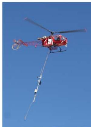
Die Station wird im Tal komplett vormontiert, in Betrieb genommen und getestet und danach per Helikopter in den Anker eingesetzt.
